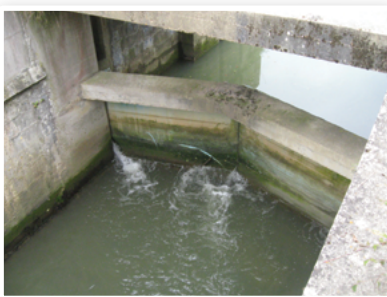
La porte à la mer, dite «écluse Marmin» se ferme lors des gros coefficients de marée
