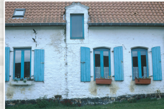
Un patrimoine architectural rural traditionnel remarquable de la vallée
