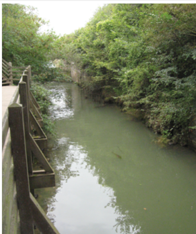
Le canal Napoléon, au niveau du pont de la RD 940
