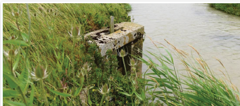
Une écluse à restaurer et à gérer
