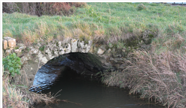
Pont à voûte en maçonnerie de pierres
